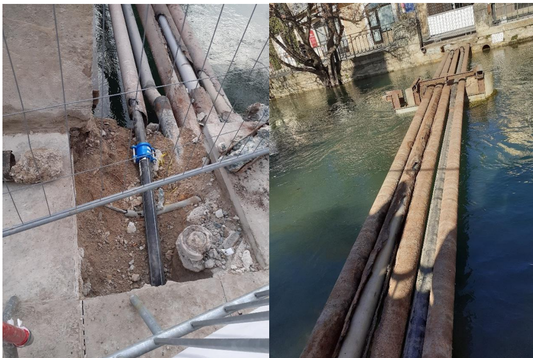
Passerelle du 18 juin à L'Isle-sur-la-Sorgue
